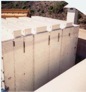
列格干法危险有毒化学品气体处理装置能够处理应对罐内储满Cl<sub>2</sub>/SO<sub>2</sub>时罐体全部泄漏的事故。装置可以处理68kg，1吨，2吨和3吨以上的Cl<sub>2</sub>/SO<sub>2</sub>/NH<sub>3</sub>危险化学品气体泄漏事故，处理后排放的有毒气体浓度小于25ppb。
